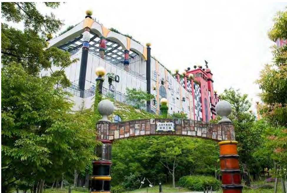
Рисунок 1 – Мусоросжигательный завод в Осаке (Япония) [3]
